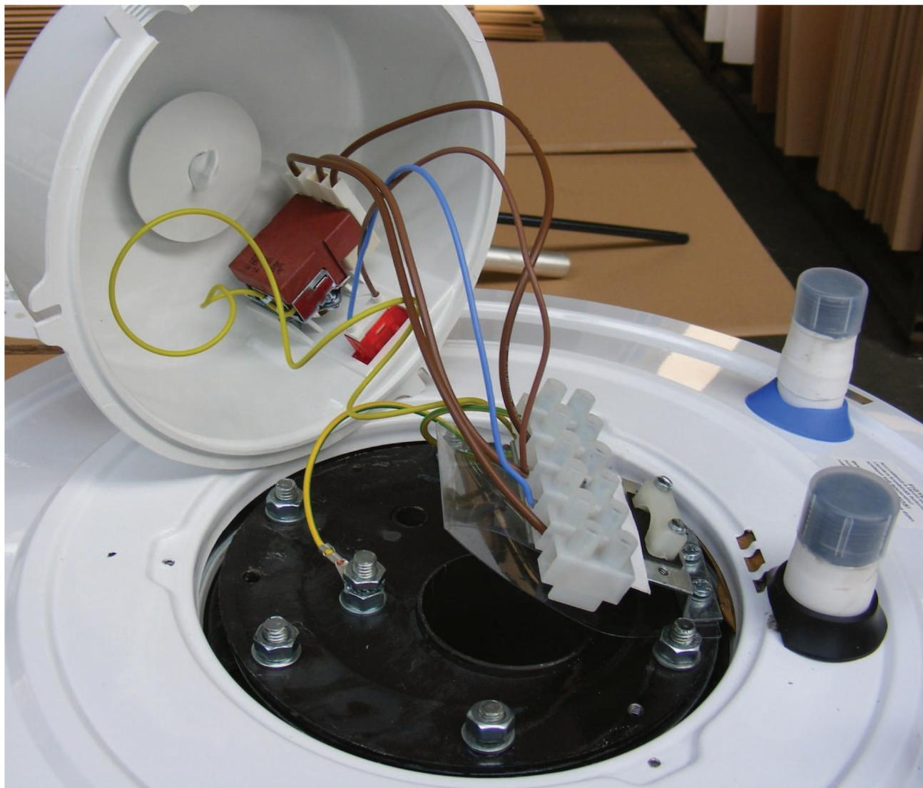
**1. lépés: Feszültségmentesítjük,** utána a szteatitos elektromos szett beszereléséhez, vegyük ki a fenéklap csavarjait és vegyük le a fedelet. Így az elektromos szerelvénytér hozzáférhetővé válik. **(HU)**
